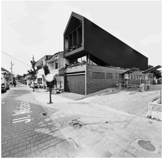
Akses Pintu Barat, Jl. Kedasih
