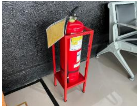
Gambar 5.1 APAR 12 Kg di Area Bertiket Stasiun
