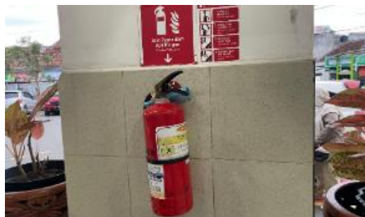
Gambar 5.2 APAR 3 Kg di Area Tidak Bertiket Stasiun
