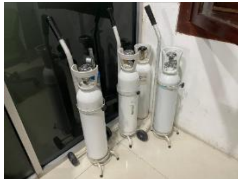
Gambar 5.9 Fasilitas Tabung Oksigen 0,5 m 3
