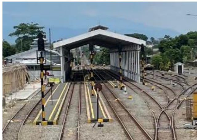
Gambar 5.14 Kanopi Peron Stasiun Tasikmalaya
