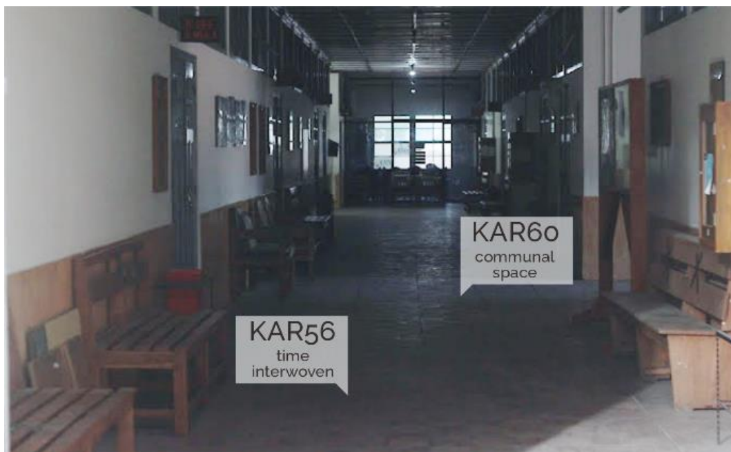
Gambar 5. 12 Kondisi ruang komunal dan akses penghubung antar bangunan.
