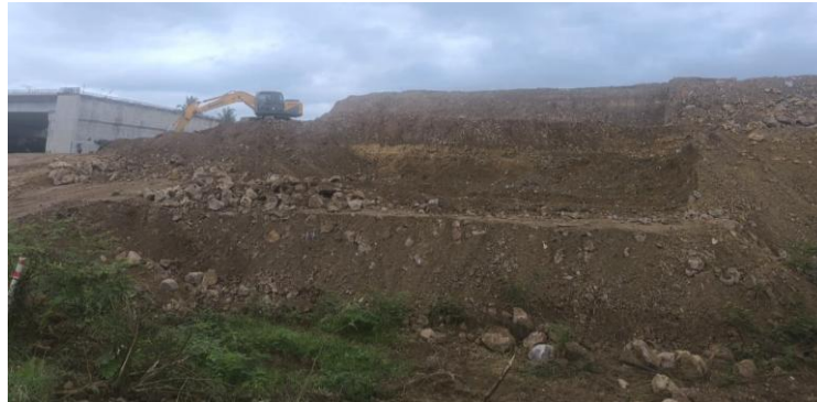
Gambar 5. 5 Pekerjaan Pemadatan Tiap Lapisan
