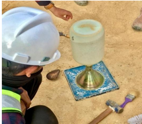
Gambar 5. 6 Pekerjaan Uji Kepadatan Sand Cone
