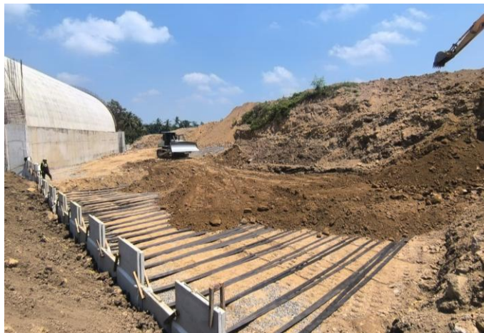
Gambar 5. 8 Pekerjaan Pengamanan Lereng Sementara (Sumber : PT Eskapindo Matra, MCI)
