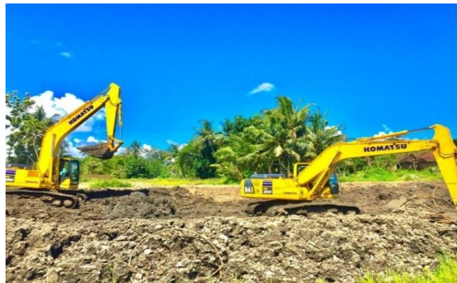
Gambar 5. 2 Pekerjaan Pengupasan Top Soil
