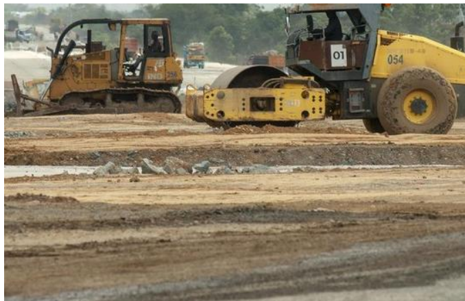
Gambar 5. 3 Pekerjaan Pembuatan Lapisan Tanah
