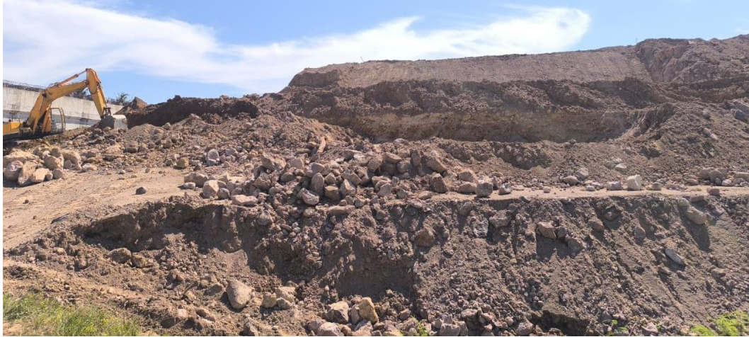
Gambar L-3.1 Sedang Berlangsung Pekerjaan Pemerataan Timbunan
