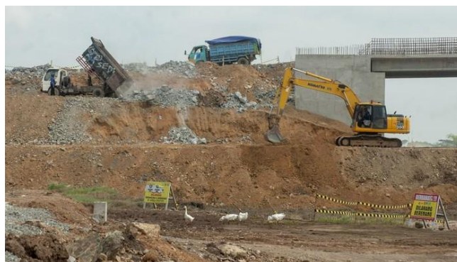
Gambar 5. 7 Pekerjaan Pembentukan Lereng
