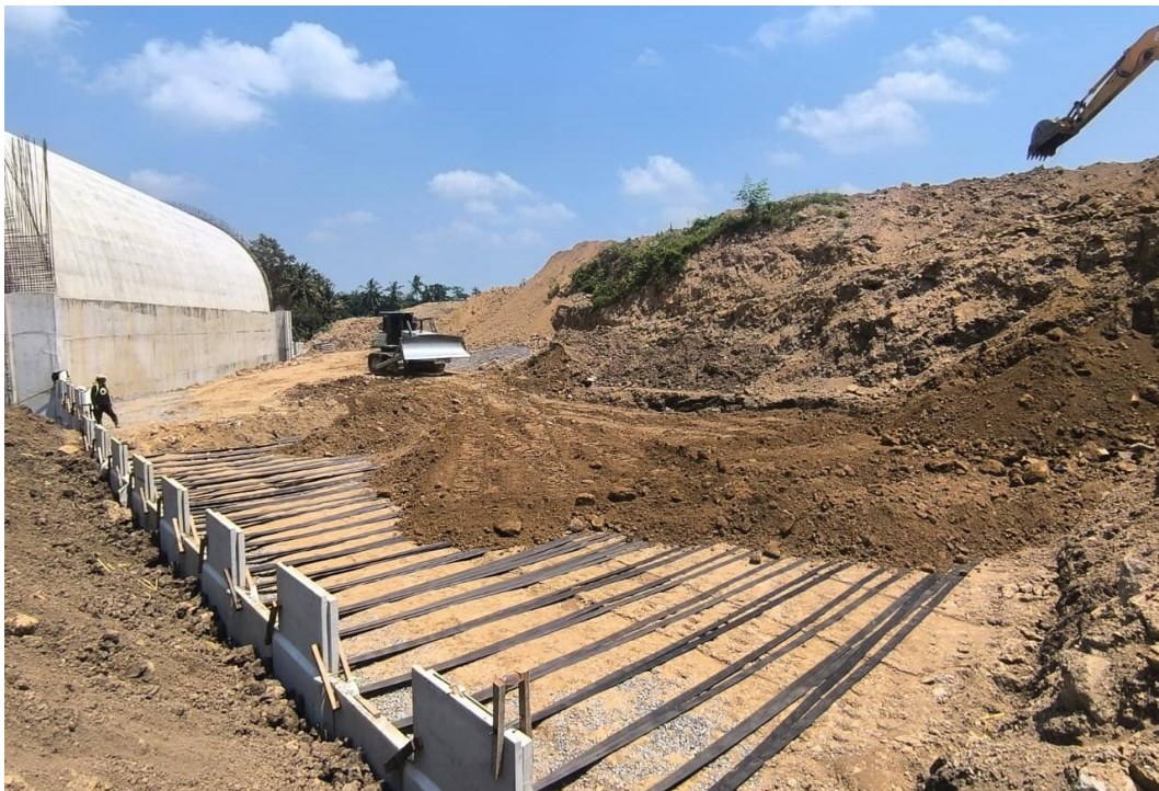
Gambar L-3.2 Sedang Berlangsung Penimbunan Tanah dengan Penguatan Lereng di Dekat Abutment
