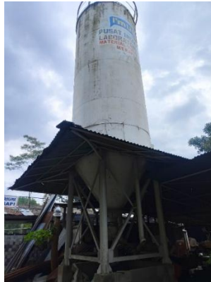
Gambar 4.17 Silo Penyimpanan Semen Portland
