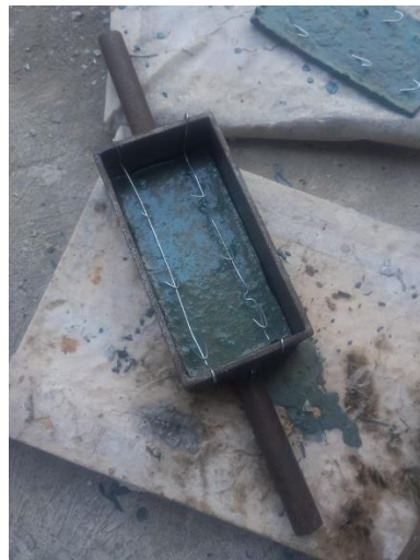
Pencetakan Lapisan Atas Paving
