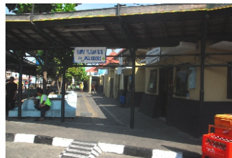
Gambar 8. Bangunan kantor. Sumber: Dokumentasi pribadi, 2014
