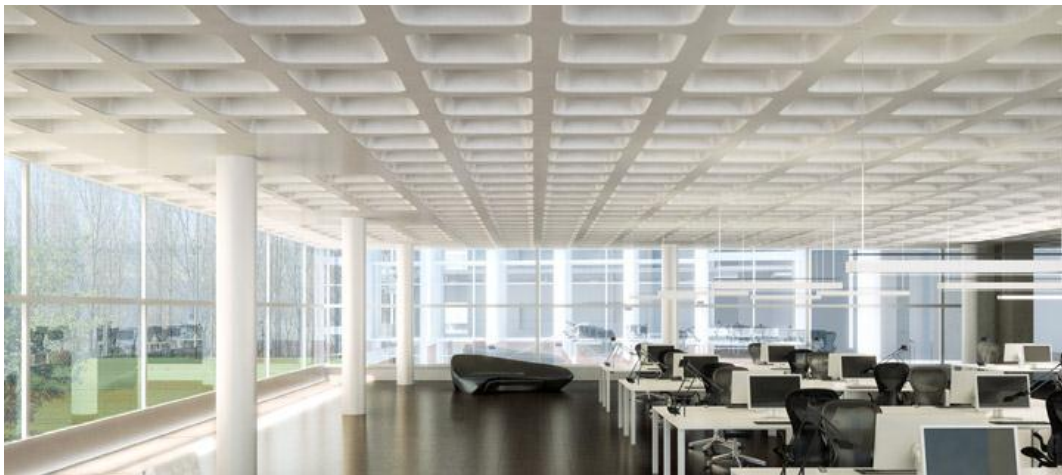
Gambar 2.9 Waffle Slab Pada Gedung Perkantoran
