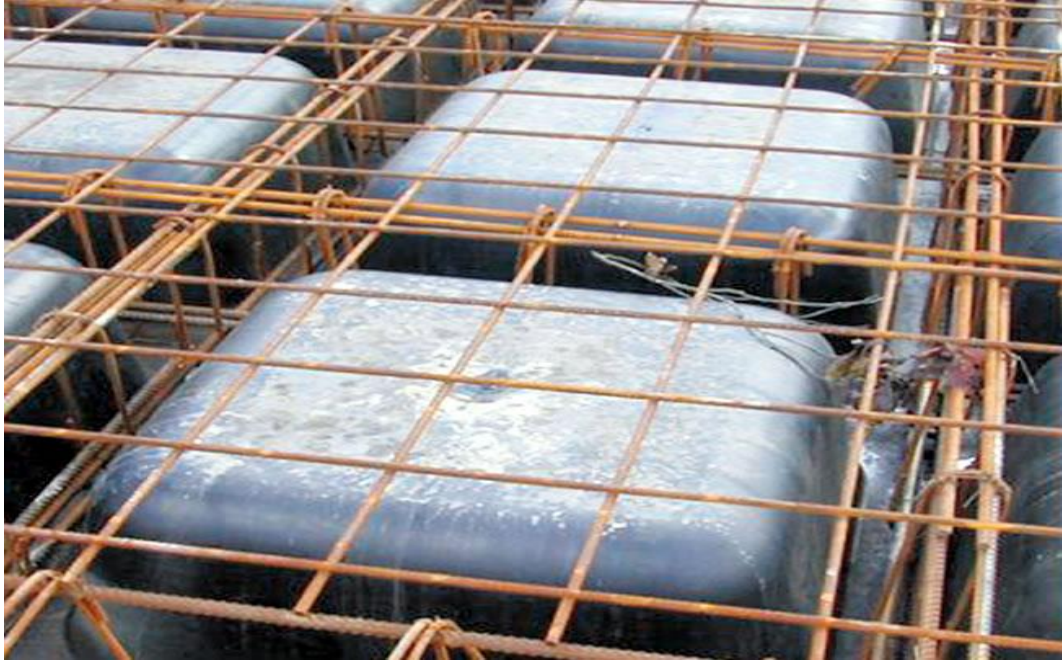
Gambar 2.8 Cetakan Untuk Membuat Waffle Slab Dan Penulangan
