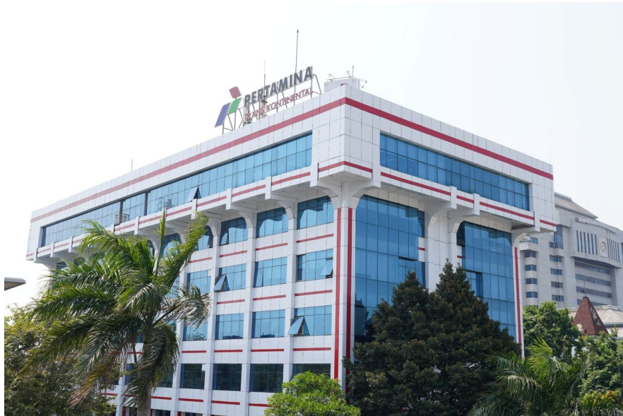
Gambar 4. 1 Gedung Pertamina Trans Kontinental
