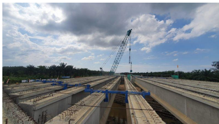
Gambar L 1.4 Pemasangan girder ke pierhead
