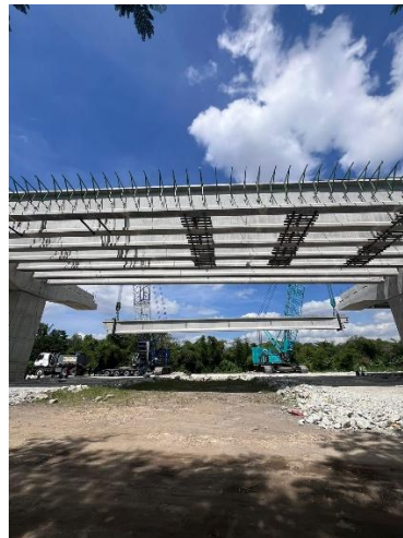
Gambar L 1.4 Pemasangan girder ke pierhead
