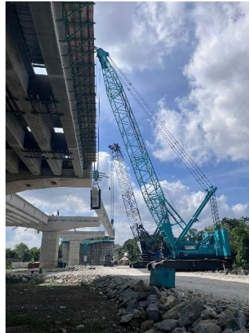
Gambar L 1.3 Pengangkatan girder dari boogie
