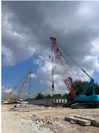
Gambar L 1.1 Pengangkatan girder dari stokyard ke boogie
