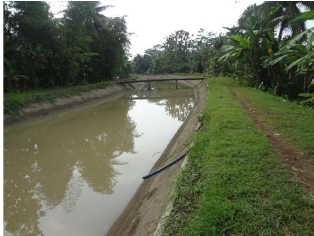
Gambar 5.10 Saluran Induk Sumpiuh di BS 10
