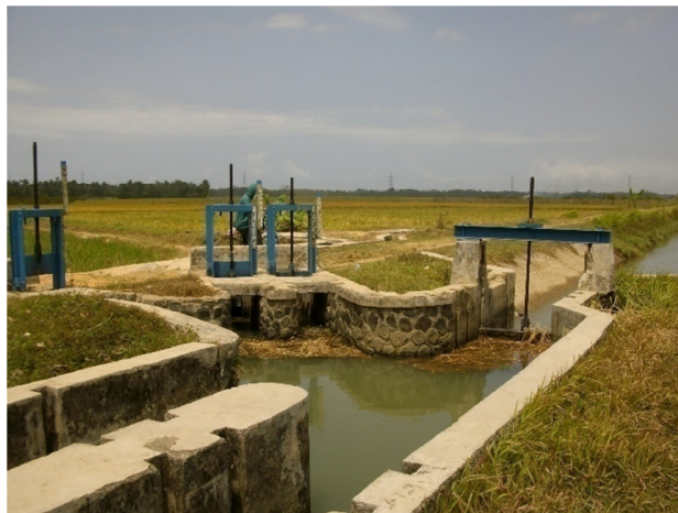
Gambar 5.5 Bangunan Bagi Doplang 3 (BDp 3)
