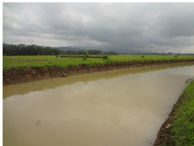
Gambar 5.7 Saluran Induk Sumpiuh di BS10
