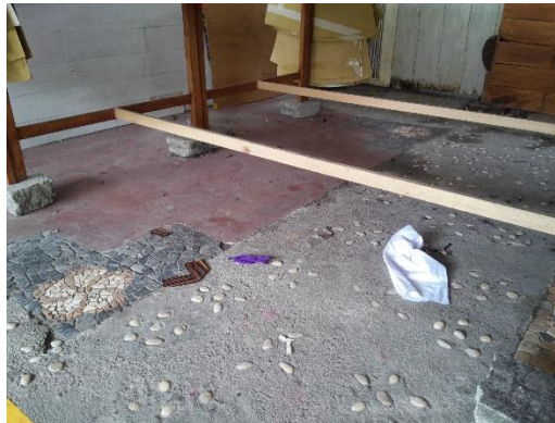
Gambar 4. 6 Kondisi Lantai Stasiun Kerja Potong
