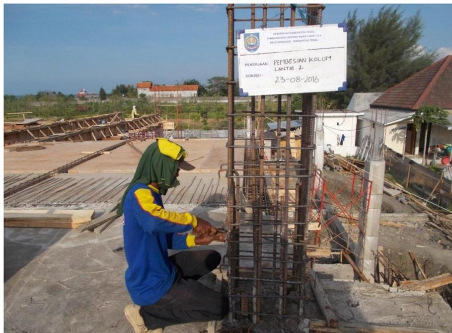
Gambar 10 Pekerjaan Pembesian Kolom Lantai 2
