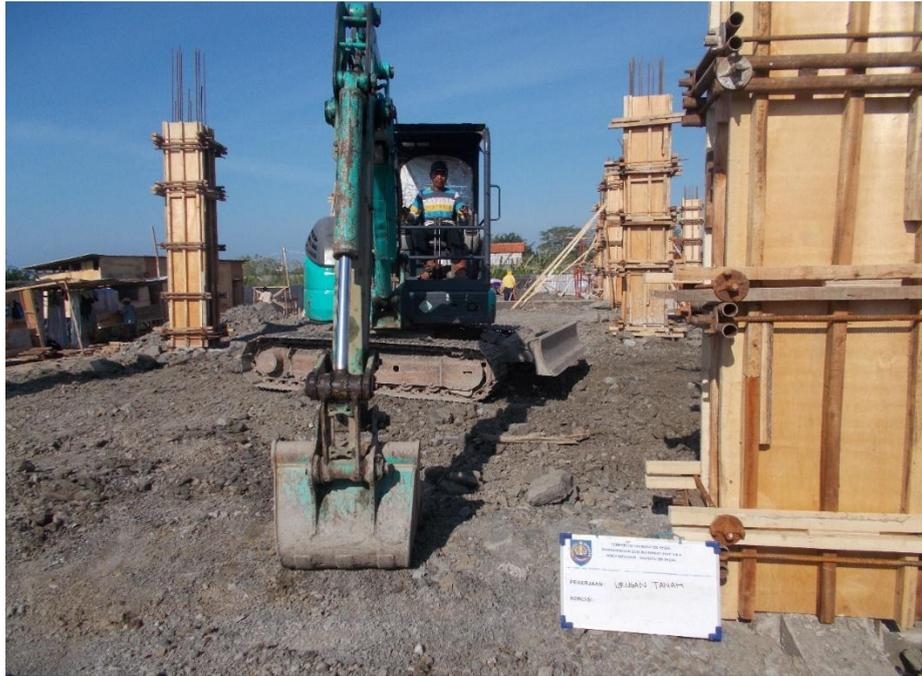
Gambar 5 Pekerjaan Urugan Tanah
