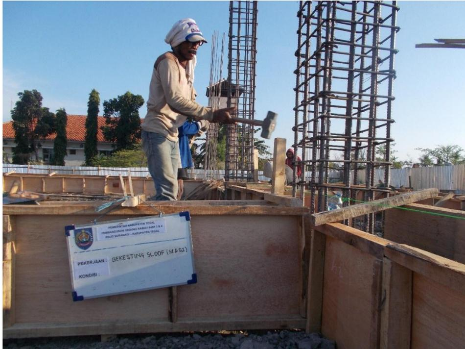
Gambar 3 Pekerjaan Bekisting Sloof
