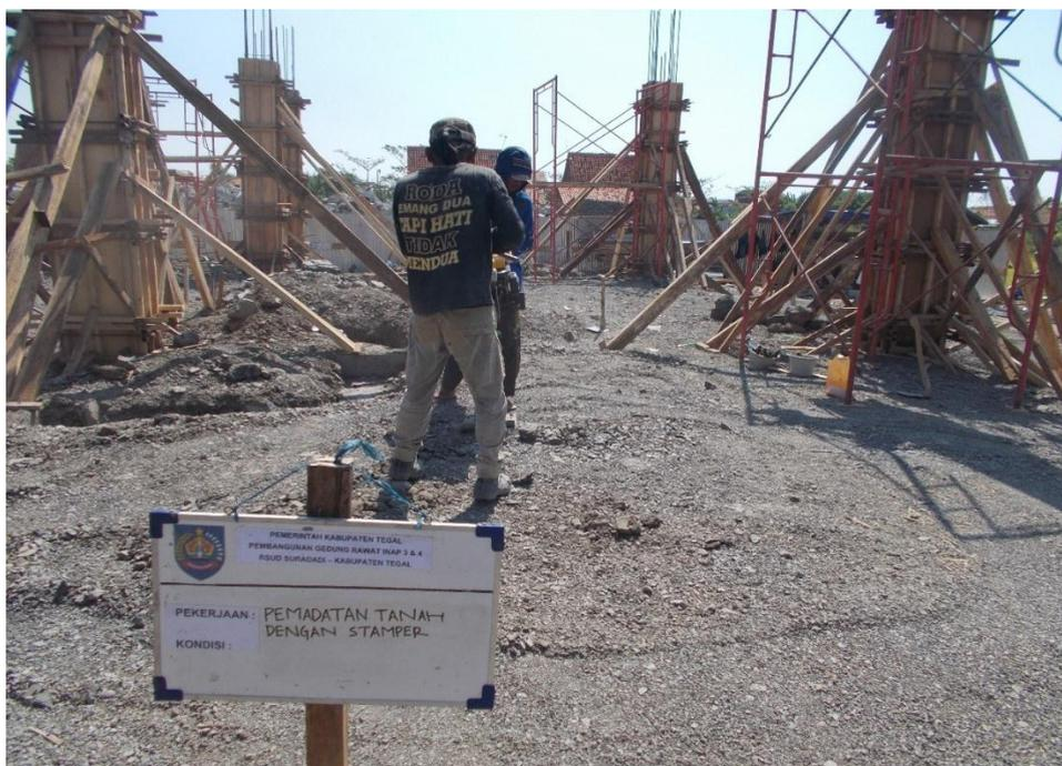
Gambar 8 Pekerjaan Pemadatan Tanah dengan Stamper
