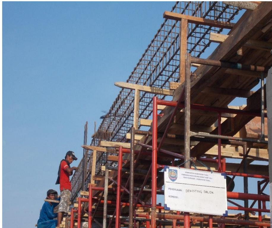
Gambar 9 Pekerjaan Bekisting Balok
