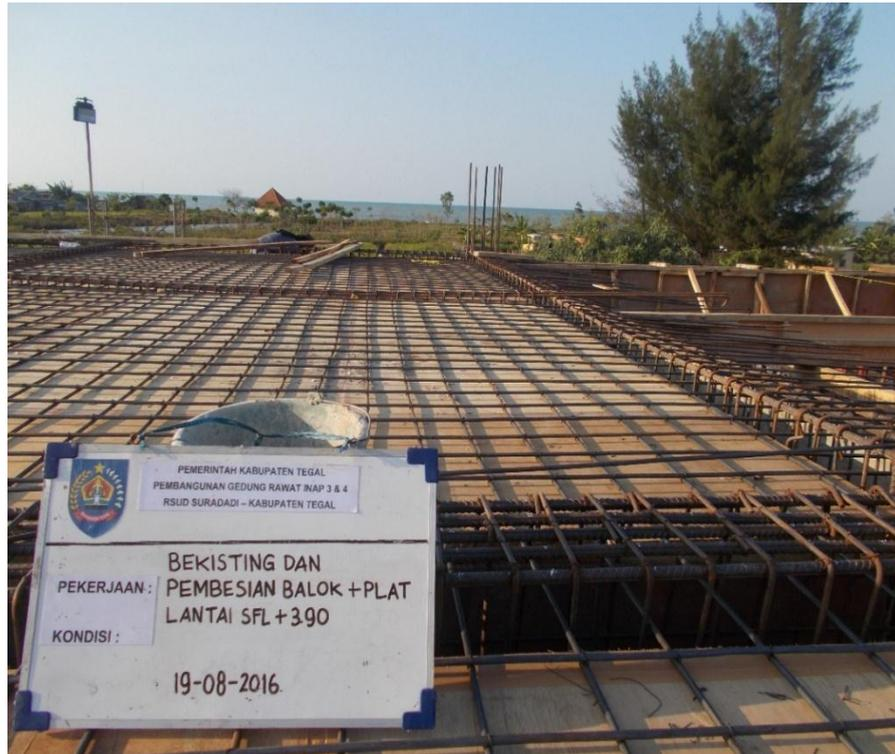
Gambar 6 Pekerjaan Bekisting dan Pembesian Balok dan Plat
