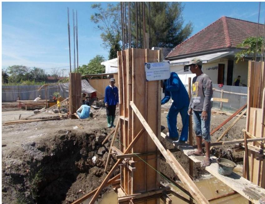
Gambar 4 Pekerjaan Beton Ready Mix Kolom
