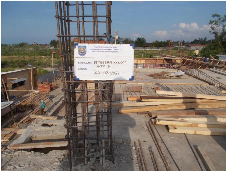
Gambar 7 Pekerjaan Pembesian Kolom Lantai 2
