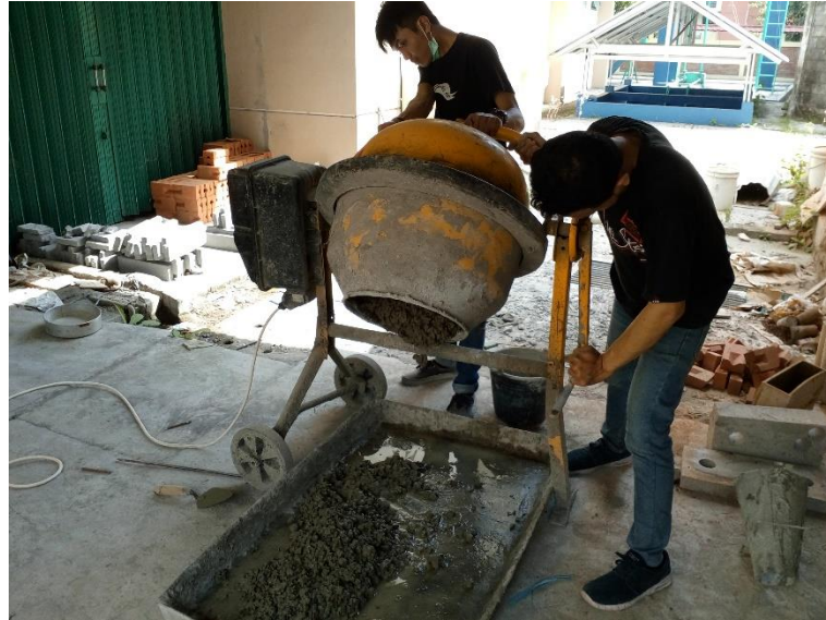
Gambar L-13.1 Pembuatan Adonan Beton
