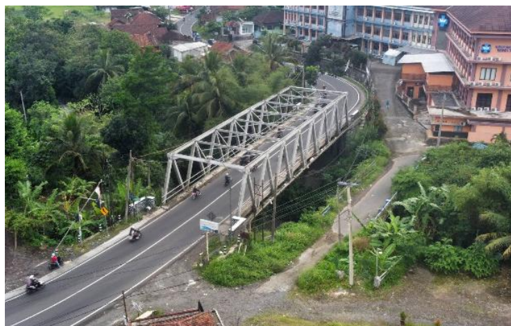
Gambar 4.1 Lokasi Jembatan Cikunir (Sumber : Google Maps)
