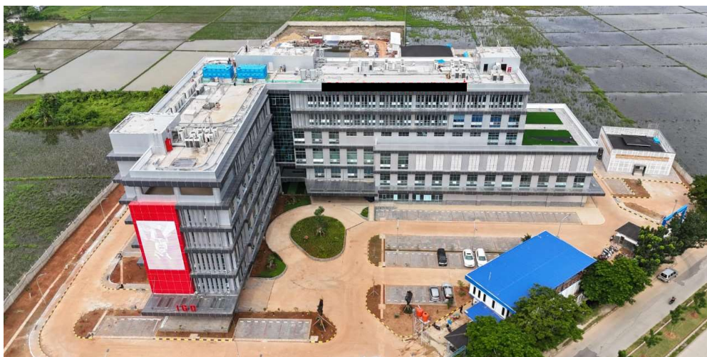
Gambar 1.2 Tampilan Bangunan Eksisting
