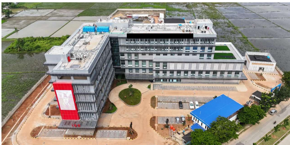
Gambar 4.1 Tampilan Bangunan Eksisting
