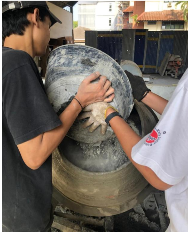
Gambar L-8. 3 Proses Pencampuran Bahan dan Pengadukan
