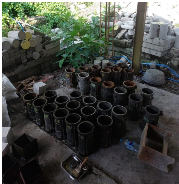
Gambar L-8. 2 Proses Persiapan Alat Bekisting
