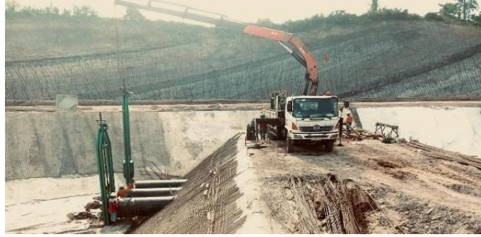
Gambar L-5.10 Pemasangan Pintu Air
