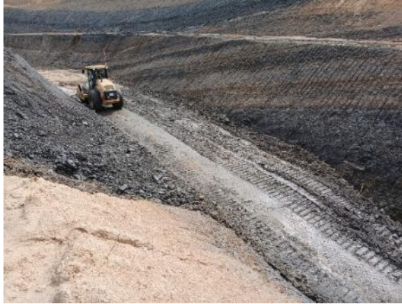
Gambar L-5.4 Pemadatan Tanah
