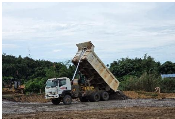
Gambar L-5.3 Pembuangan Tanah
