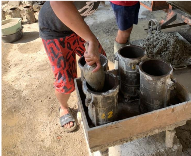
Gambar 6. 3 Proses Memasukkan Beton Segar ke Bekisting
