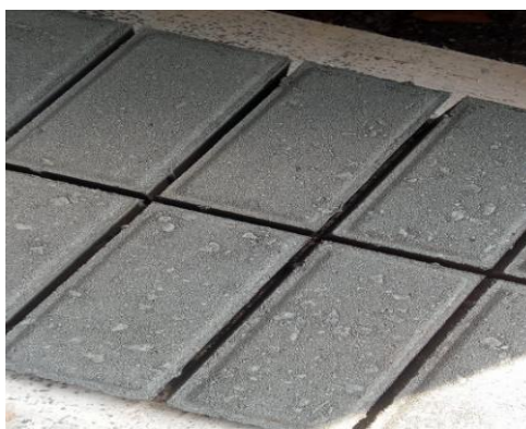
Gambar L-3. 3 Paving Sudah Tercetak
