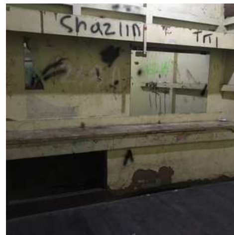
Gambar 16: Kerusakan Taman Budaya di Pontianak Sumber: googleimages.com(2025)
