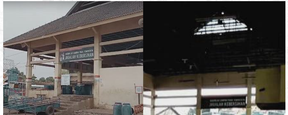
Gambar 1.15 Kondisi TPI Tawang
