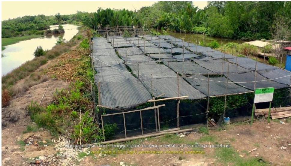
Gambar 2.49. Bedeng dengan Parapet
