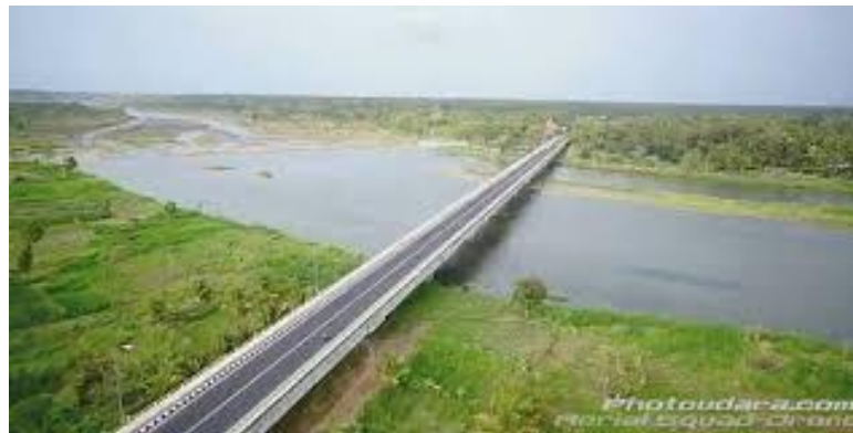
Gambar 4. 2 Jembatan Srandakan II (Sumber : www.facebook.com )
