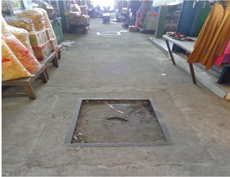
Gambar 4.11 Sumur Resapan
