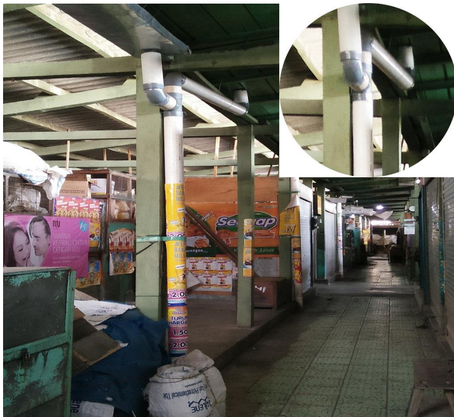
Gambar 4.6 Penanganan Air Limpasan Hujan Untuk Atap
