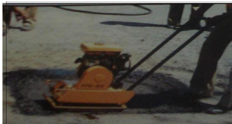
Gambar 5.16 Pemasangan Agregat (Sumber: Bina Marga, 2011)
