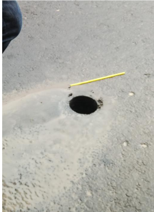
Gambar L-5.1 Pengambilan Uji Core Drill Lajur Turi-Pakem Sta. 2+800
