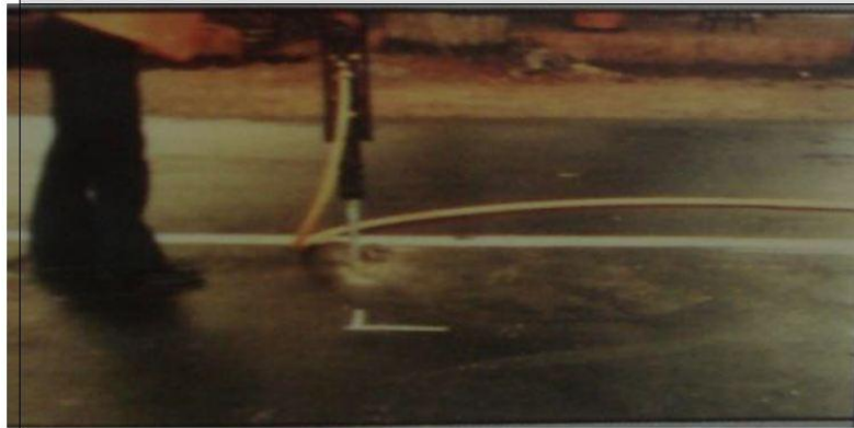
Gambar 5.15 Penggalian Pada Daerah Yang Diperbaiki (Sumber: Bina Marga, 2011)
