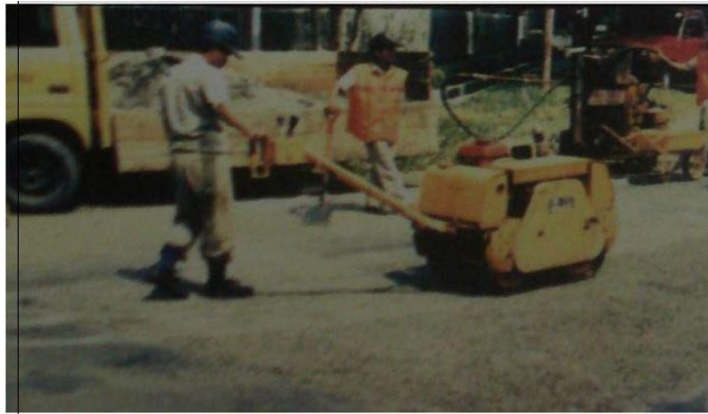
Gambar 5.13 Pematatan Menggunakan Baby Roller
