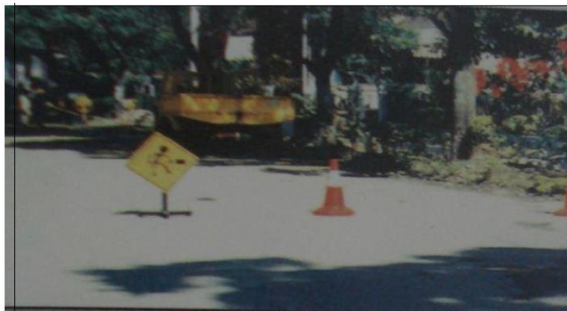
Gambar 5.14 Penempatan Rambu Pengaman
