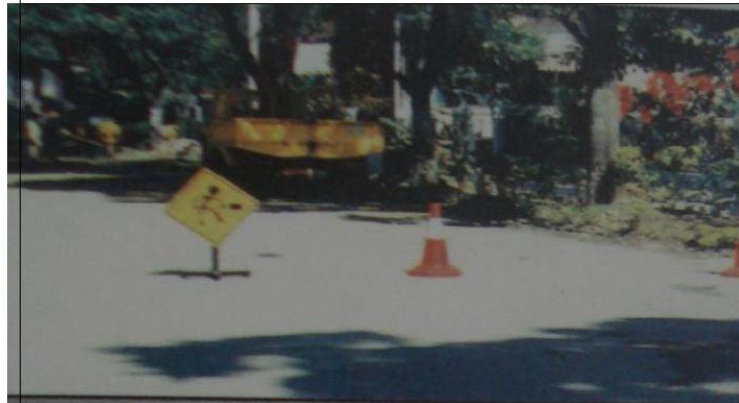
Gambar 5.11 Penempatan Rambu Pengaman
