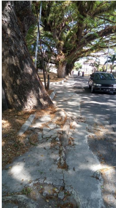
Gambar 4.8 Ruang Terbuka Hijau (RTH) sempadan jalan
