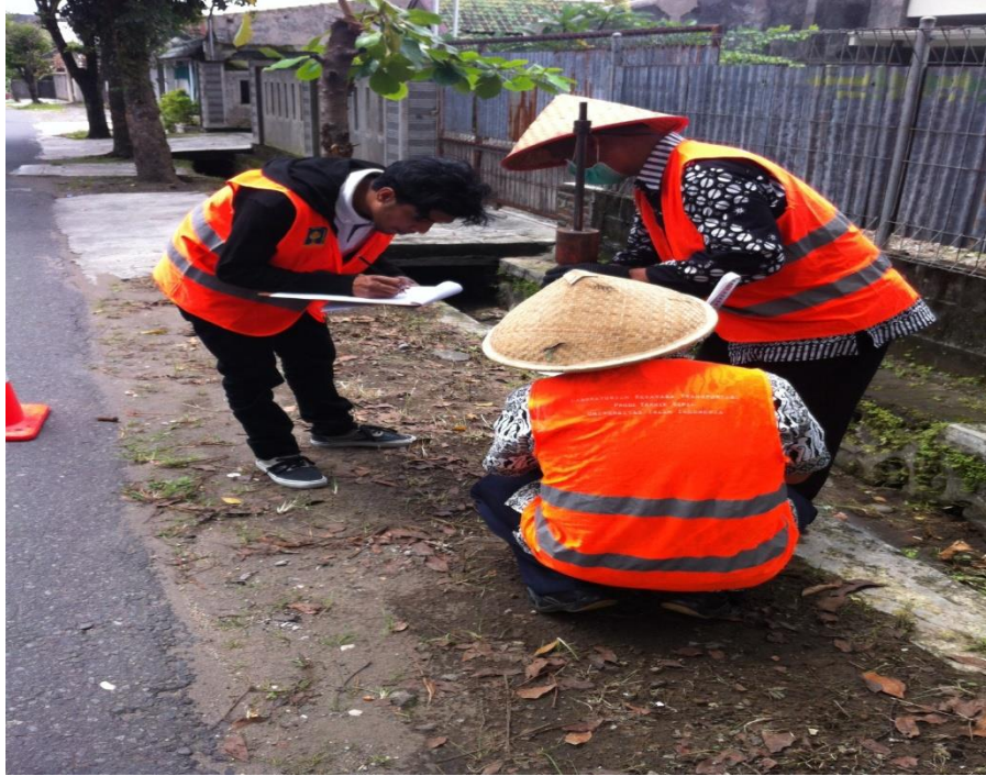
Gambar L-10.1 Gambar Pengambilan DCP dilapangan
