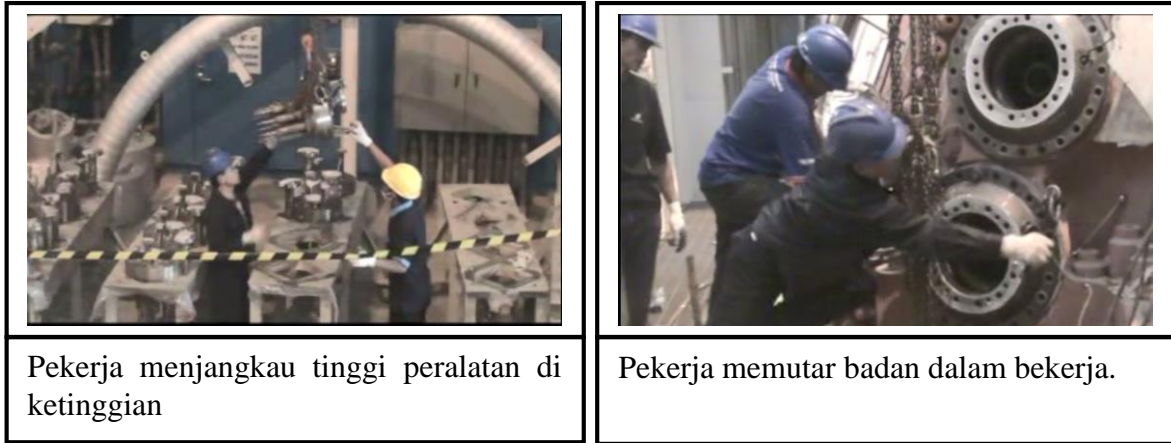
Gambar 4.5. Aktivitas pengambilan spare part dengan posisi tangan diatas bahu dan pembukaan gas turbine man hole dengan posisi tulang punggung memutar, badan posisi jongkok, penekanan atau menahan peralatan dengan posisi dibawah tangan.
