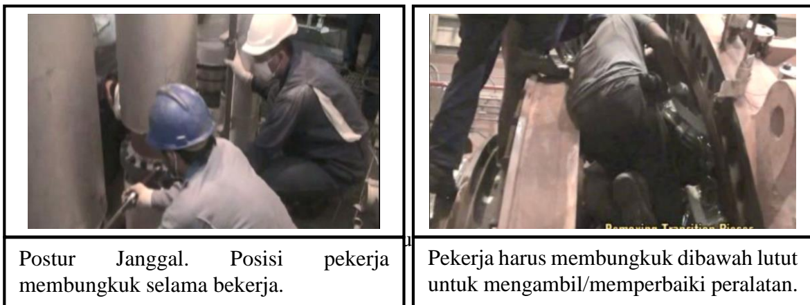
Gambar 4.4. AKTIVITAS perbaikan kebocoran pipa boiler/HKSG posisi membungkuk dan perbaikan gas turbine dengan posisi tulang belakang memutar
