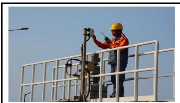
Operator mengoperasikan peralatan Balance of Plant (BOP) dari local
