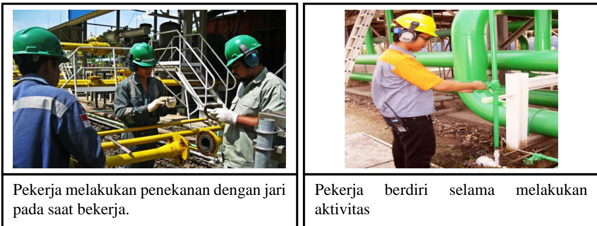
Gambar 4.6. Aktivitas perbaikan fuel gas pipe dengan posisi berdiri dengan waktu yang lama dan dibawah terik matahari.
