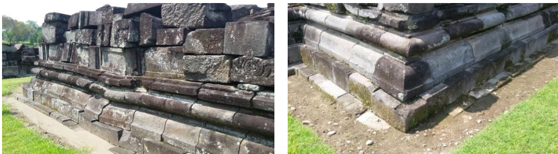
Gambar 5.1 Penurunan Tanah pada Candi Perwara
