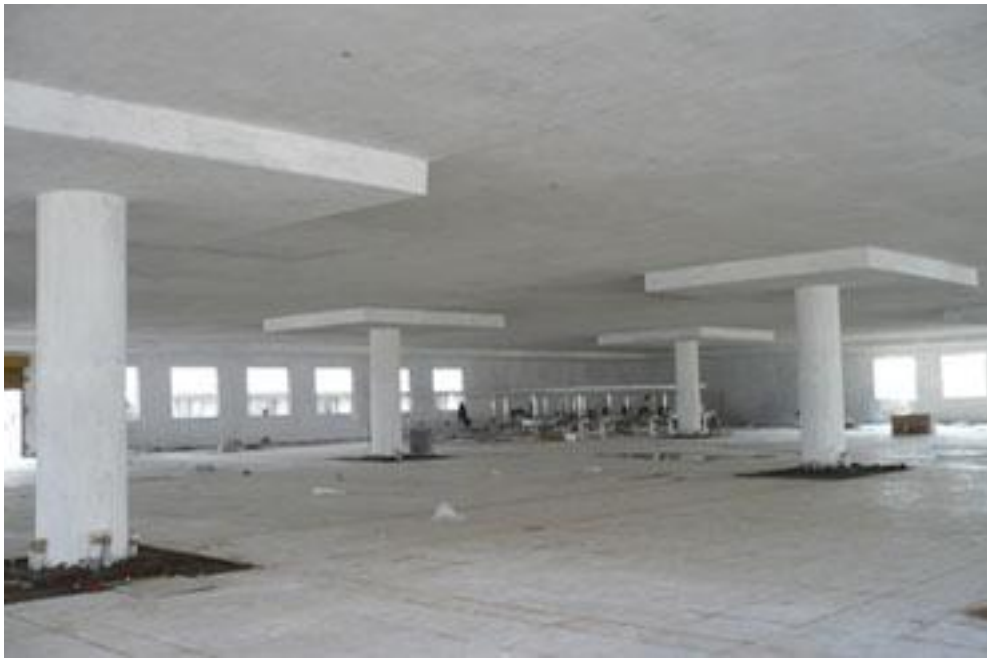
Gambar 3.5 Penerapan Flat Slab (Pelat Cendawan) Pada Bangunan.
