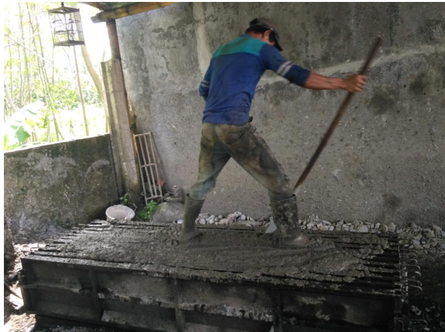
Gambar 5.33 Perataan beton (sisi dalam) dengan besi pemadatan
