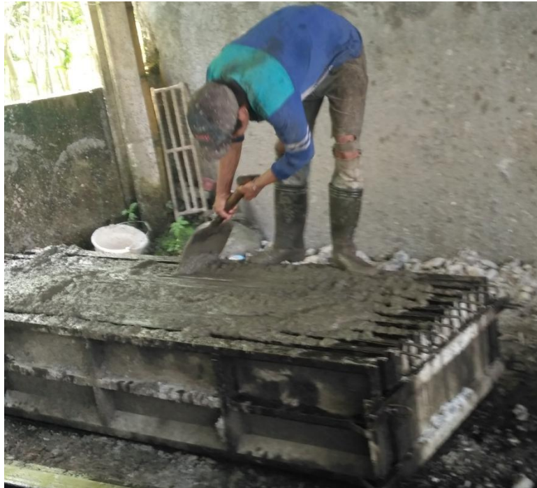
Gambar 5.34 Perataan permukaan bekisting dengan sekop
