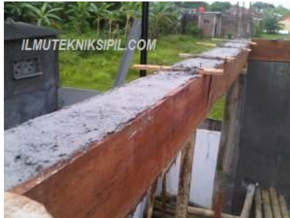
Gambar 2.2. Bekisting konvensional (Sumber: Syah, 2014)
