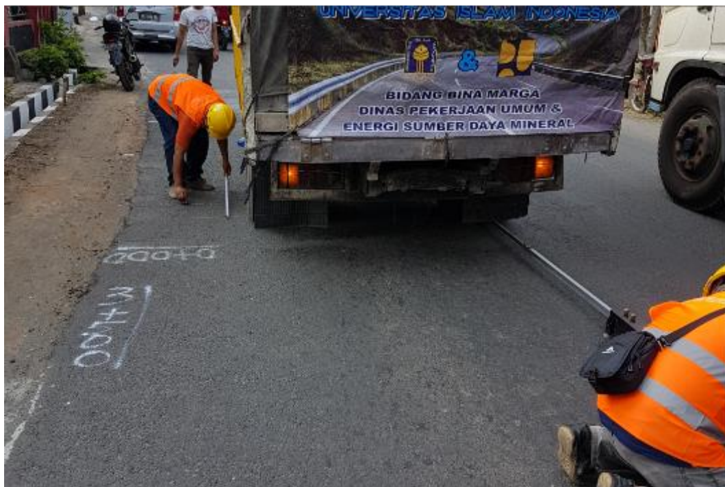
Gambar L-5. 8 Pengujian Lendutan Balik Dengan Benkelman Beam
