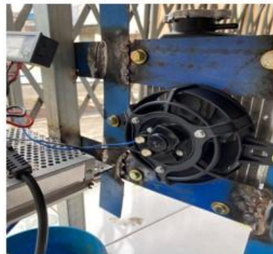
Step 3 Pemasangan kipas elektrik
