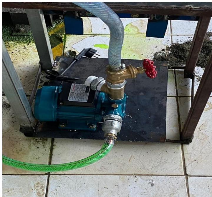
Gambar 3.10 Pemasangan Pompa air
