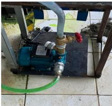
Step 4 Pemasangan pompa air
