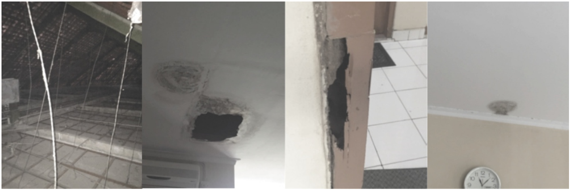
Kondisi eksisting interior Asrama MMTC Blok III Yogyakarta sumber: dokumentasi pribadi
