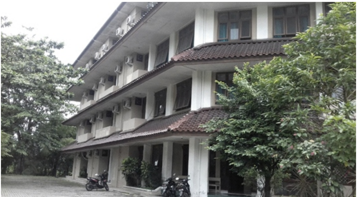
Kondisi eksisting eksterior Asrama MMTC Blok III Yogyakarta sumber: dokumentasi pribadi
