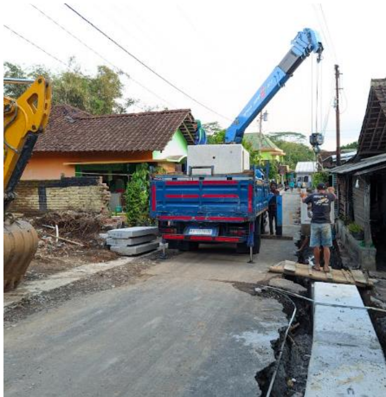
Gambar 5.8. Foto Pemasangan U Ditch Precast Pabrik dengan Crane
