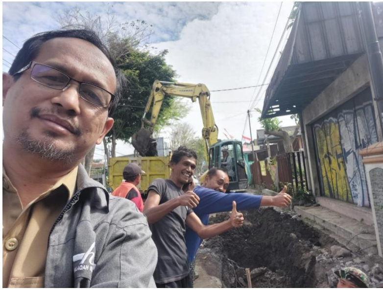
Gambar 5.7. Foto Pekerjaan Galian Saluran dengan Exavator dan Dump Truk
