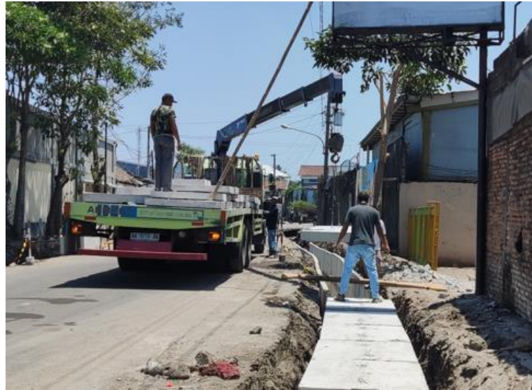
Gambar 5.9. Foto Pemasangan Cover U Ditch Precast Pabrik dengan Crane
