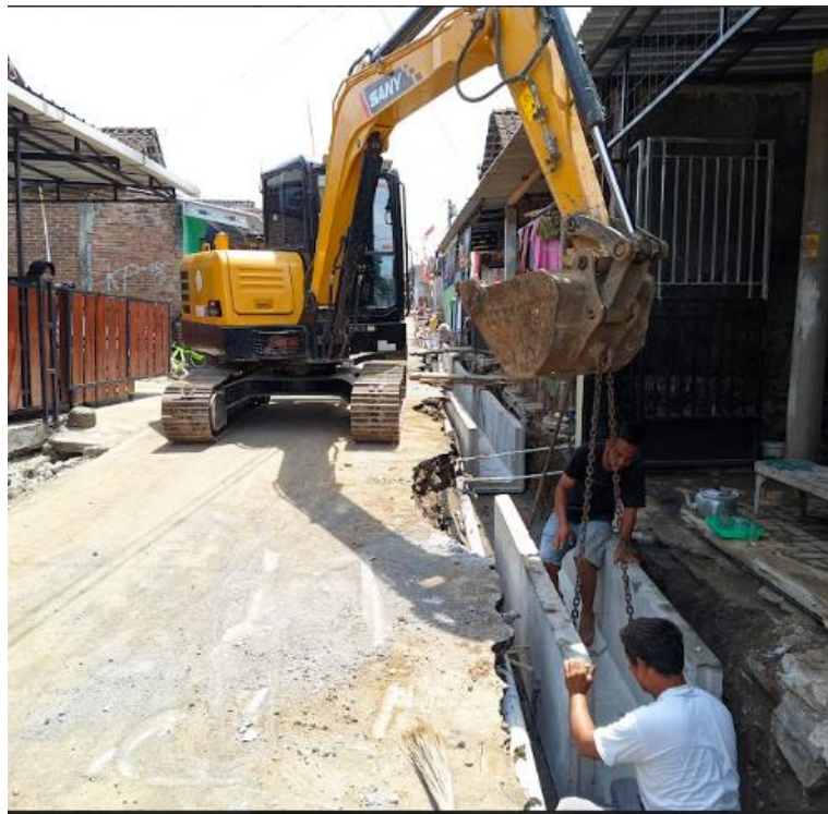
Gambar 5.10. Foto Pemasangan U Ditch Precast Pabrik dengan Excavator
