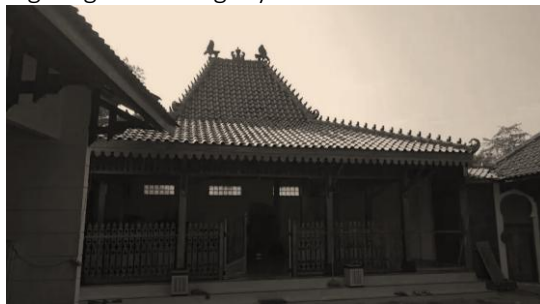
Gambar 6. Tampak Depan Bangunan (Sumber: Pribadi)
