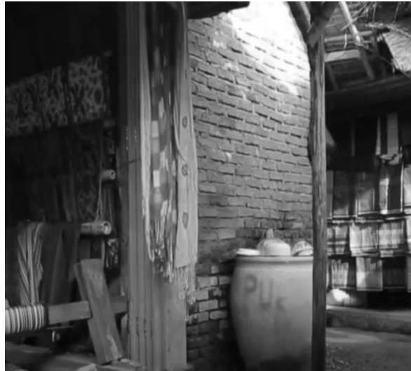
Gambar 7 Perubahan Material Dinding Sumber : Penulis, 2024
