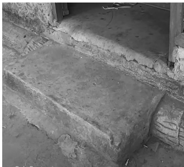
Gambar 8 Perubahan Material Dinding Sumber : Penulis, 2024
