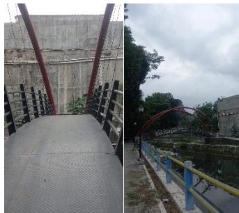
Gambar 16: Jembatan Baru Sumber: Hasil Survey, 2024
