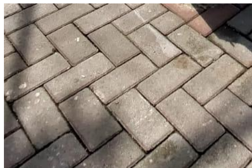
Gambar 7. Perkerasan Paving Block Sumber : Dokumentasi Penulis, 2024
