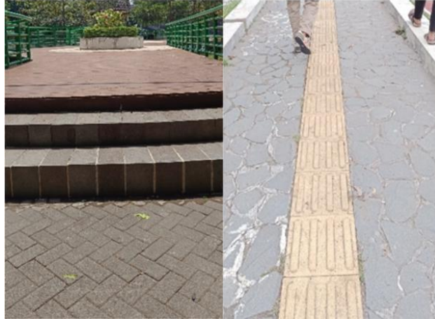
Gambar 3. Elevasi Tanpa Ramp & Guiding Block Sumber: Dokumentasi Penulis
