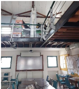
Gambar 4 Ruang terdapat mezanin terbuka di ruang 4.13
