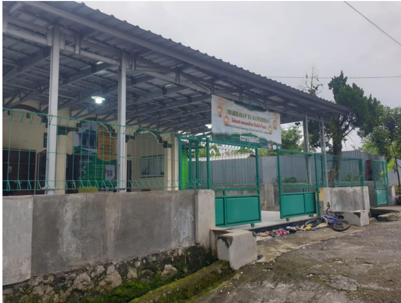
Kondisi Depan Masjid Miftahul Jannah
