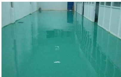
Gambar 2.11. Aplikasi PMC termoset pada lantai [23].
