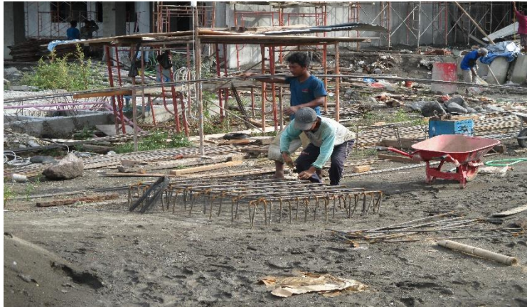
Gambar 5.2 Pekerjaan Pembesian
