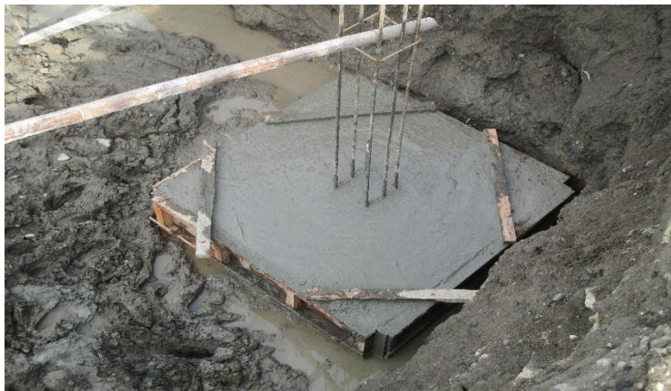
Gambar 5.3 Pekerjaan Pengecoran
