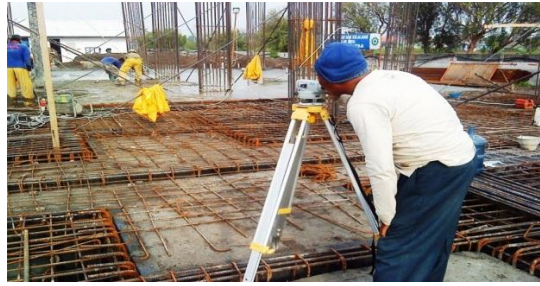
Gambar 3.2 Pekerjaan Pengukuran (Sumber : Rahmadi, 2011)
