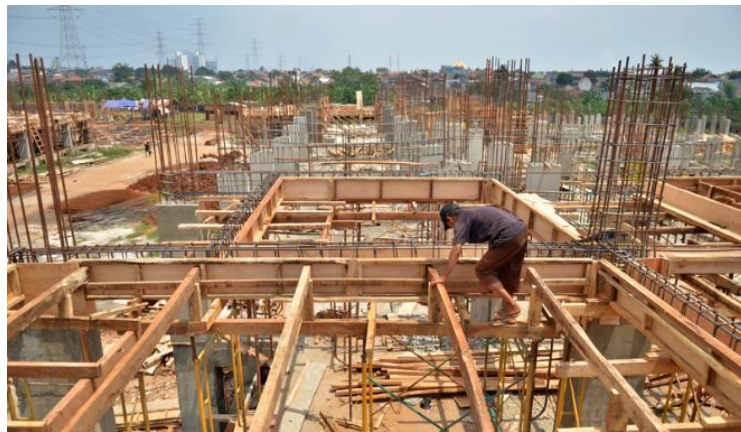
Gambar 3.4 Pabrikasi Bekisting (sumber : Purbo, 2010)
