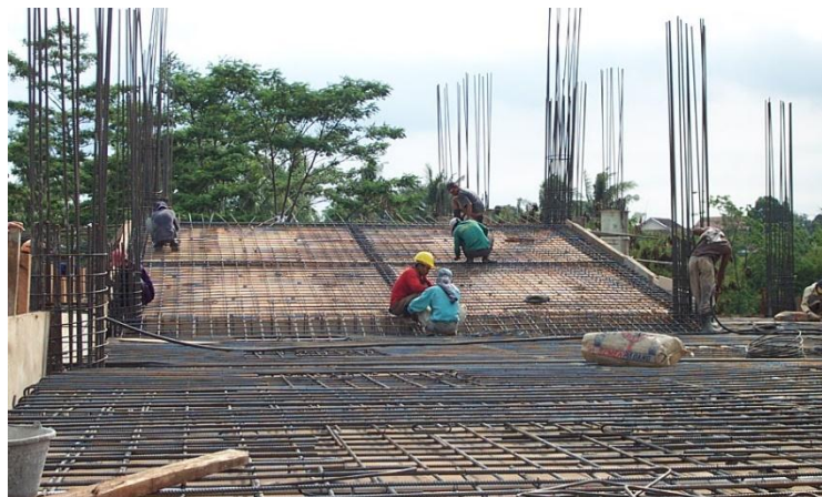
Gambar 3.3 Pabrikasi Pembesian (Sumber : Purbo, 2010)
