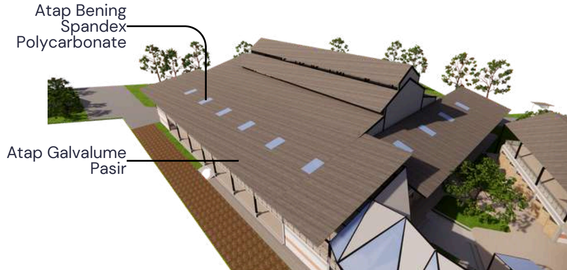
Gambar 5.7 Material Atap Bangunan Utama Pasar Sragi (Sumber: Dokumentasi Penulis)
