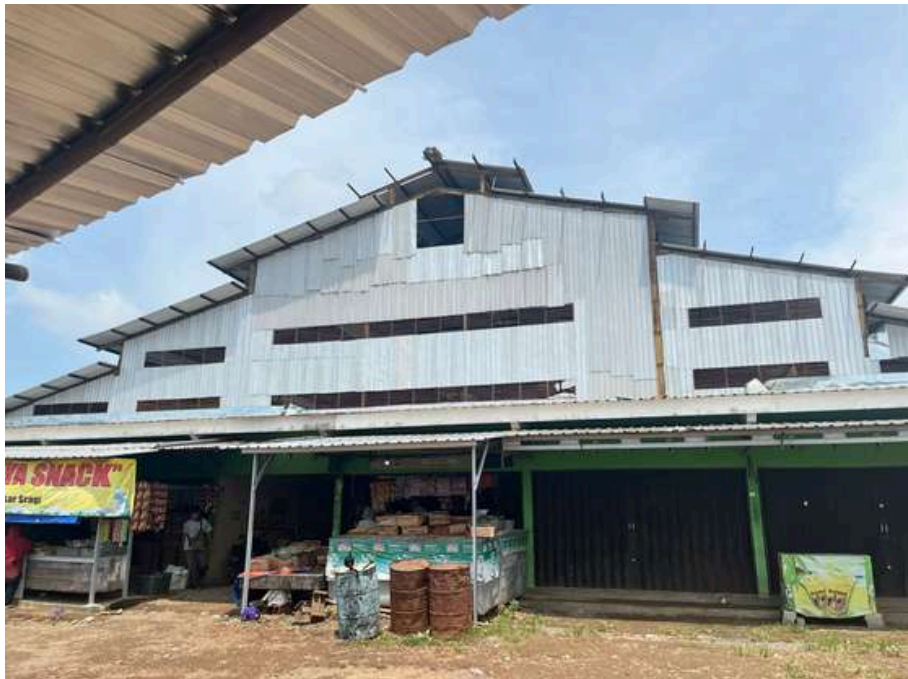
Gambar 1.2 Kondisi Bangunan Pasar Sragi (Sumber: Dokumentasi Penulis)
