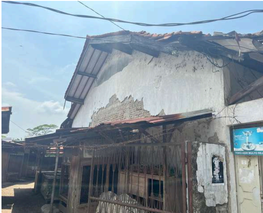
Gambar 1.6 Kondisi Bangunan Pasar Sragi (Sumber: Dokumentasi Penulis)
