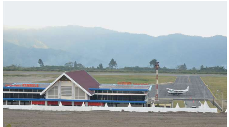
Gambar 1.6 Terminal eksisting Bandar Udara Rembele ( Sumber : Google.com )
