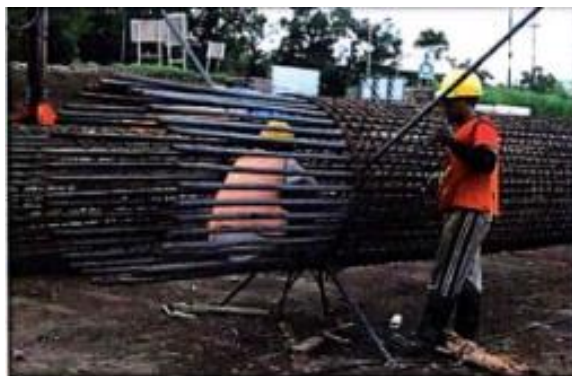
Gambar 3.27 Pembesian Bored pile (Sumber: PT ADHI-JMTM KSO, 2025)
