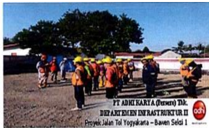
Gambar 3.12 Rapat kesadaran Keselamatan (Sumber: PT ADHI-JMTM KSO, 2025)
