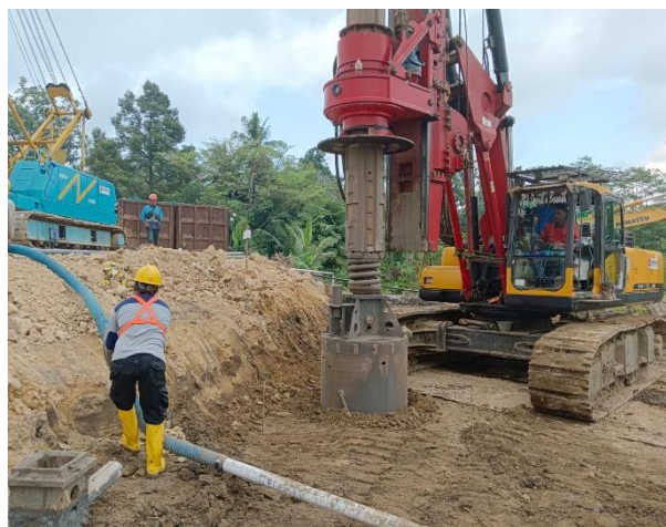
Gambar 1.1 Proses Pelaksanaan Pengeboran Bored Pile Pada Pile Cap Pier 5 (Sumber: PT. ADHI-JMTM KSO, 2025)
