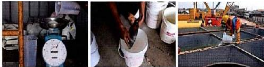
Gambar 3.14 Pencampuran Bentonite (Sumber: PT ADHI-JMTM KSO, 2025)
