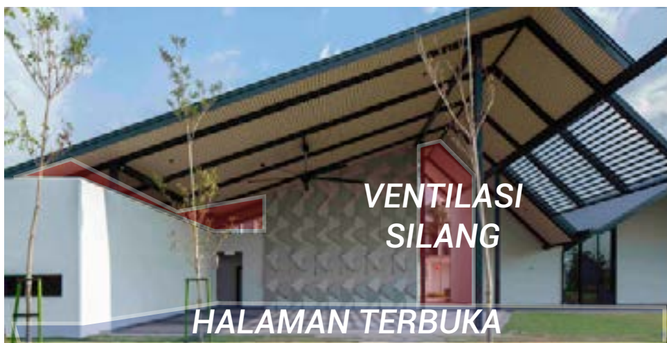
Gambar 2.43 Ventilasi Silang dan Halaman Terbuka. Sumber: Archdaily, 2025
