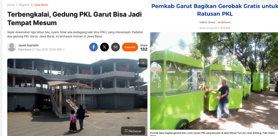
Gambar 1.22 : Terbangkalai Gedung PKL Sumber : DetikNEWS
